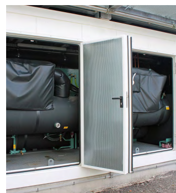
Links: Hier ist die Frontansicht des YORK® YVWA-Flüssigkeitskühlers im Kälte-Technikcontainer zu sehen. Rechts: Dieses Bild zeigt den YORK® YVWA-Flüssigkeitskühler und den sich ebenfalls im Container befindlichen Schallschutz von der Rückseite.
