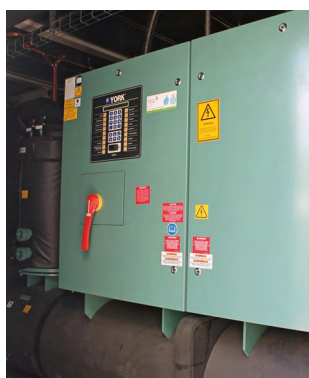
Links: Hier ist die Frontansicht des YORK® YVWA-Flüssigkeitskühlers im Kälte-Technikcontainer zu sehen. Rechts: Dieses Bild zeigt den YORK® YVWA-Flüssigkeitskühler und den sich ebenfalls im Container befindlichen Schallschutz von der Rückseite.
